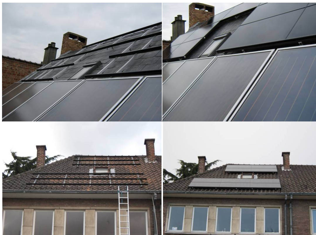
Figure 9: Avant et après le placement des panneaux (Photos SunSwitch)
