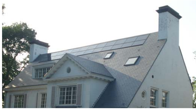
Figure 10: Modules intégrés - APERE
